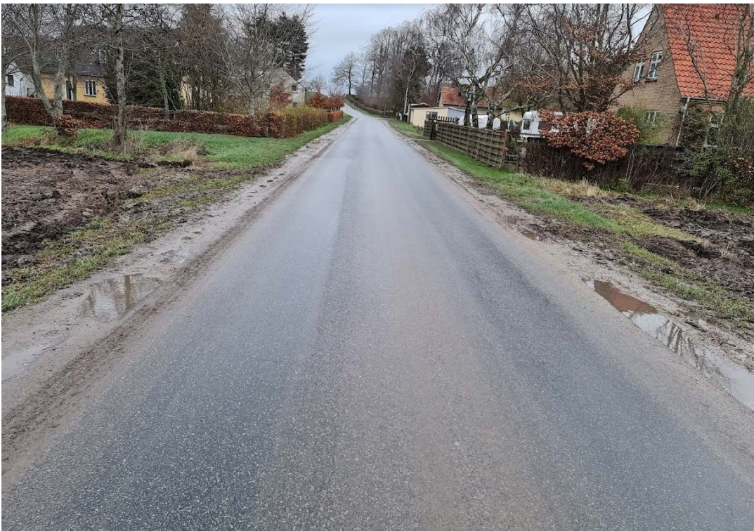
Gimlingevej ved Fodsporet. Ca. 3,8 meter bred
